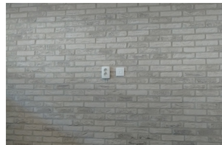
Muur gereed voor installatie
